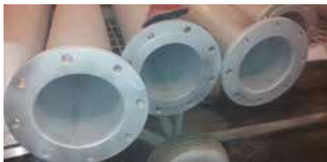
Auftragen von Belzona 1381 mit einer rotierender Sprühdüse auf Rohrinneinnenseite - vorher, während und nachher
