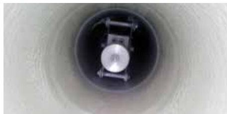
Auftragen von Belzona 1381 mit einer rotierender Sprühdüse auf Rohrinneinnenseite - vorher, während und nachher
