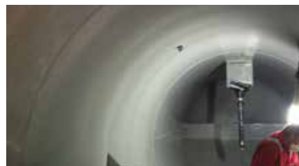
Die hellen Farben von Belzona 1593 ermöglichen eine einfache Sichtprüfung in Behältern.
