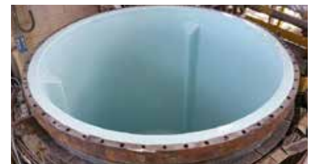
Die hellen Farben von Belzona 1593 ermöglichen eine einfache Sichtprüfung in Behältern.
