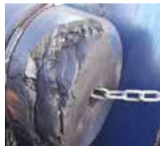
Wiederherstellung eines beschädigten Teils
