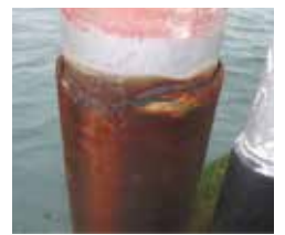
Ungleiche Materialien abgedichtet
