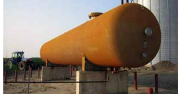
Außenkorrosion an einem Behälter
