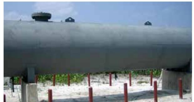
Mit Belzona 6111 beschichteter Behälter, kathodischer Schutz der Metallfläche
